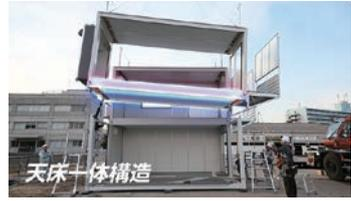
天床一体構造を採用しており、効率的な組み立てを実現しています。
