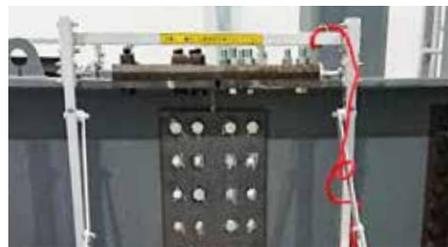
**2** 梁成サイズによって本締めを効率良く行えるように前棧の開閉が可能
