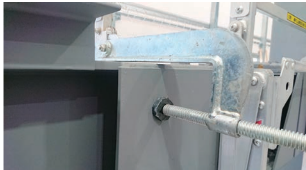
NKHRC用金具設置状態
