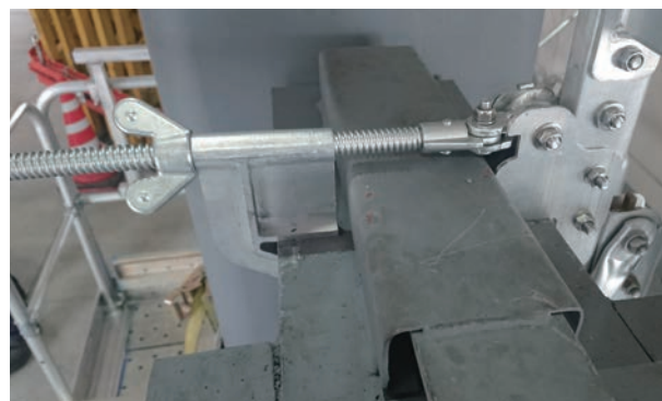
フランジ幅 200mm に設置した状況
