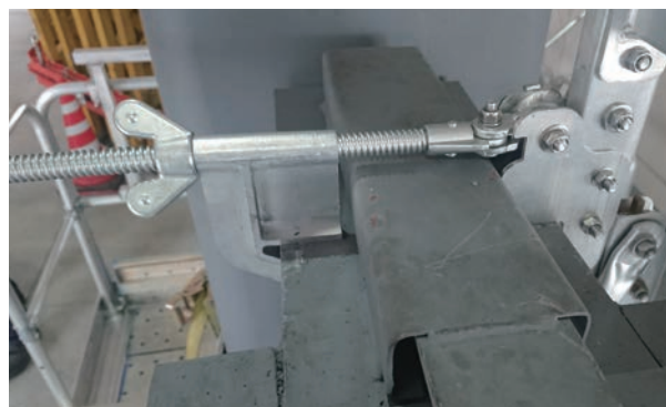
フランジ幅 200mm に設置した状況
