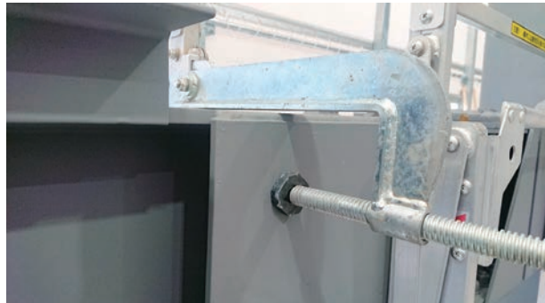
NKHRC用金具設置状態
