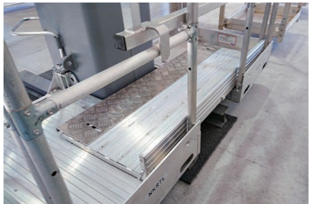
渡り足場・巾木設置後
