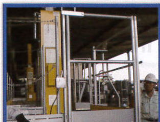
端部扉・躯体側中間扉
