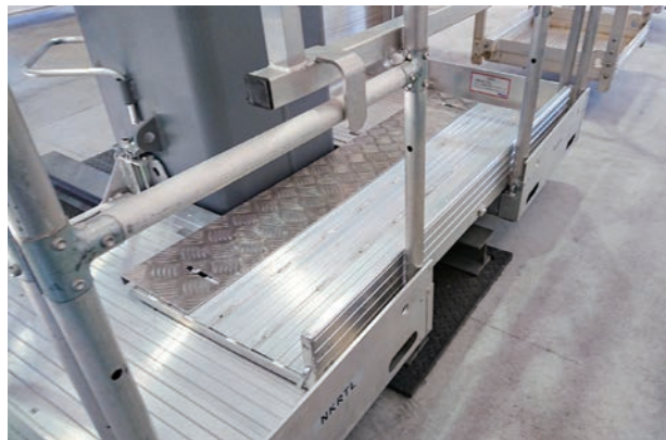
渡し足場・巾木設置後
