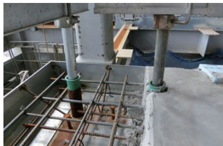
コンクリート打設後
