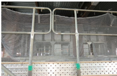
コンクリート打設前
