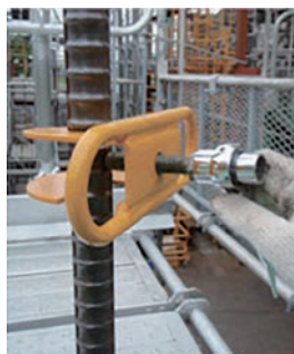
STEP2 抑えボルトを締める ソケットは21mmを使用
