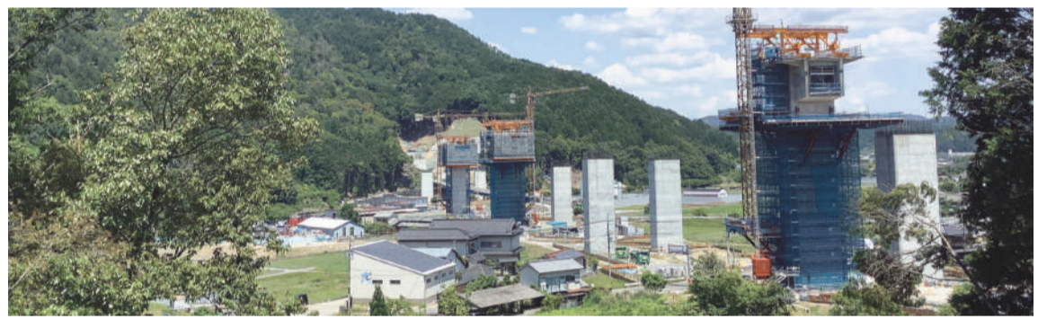
宇治田原第二高架橋
